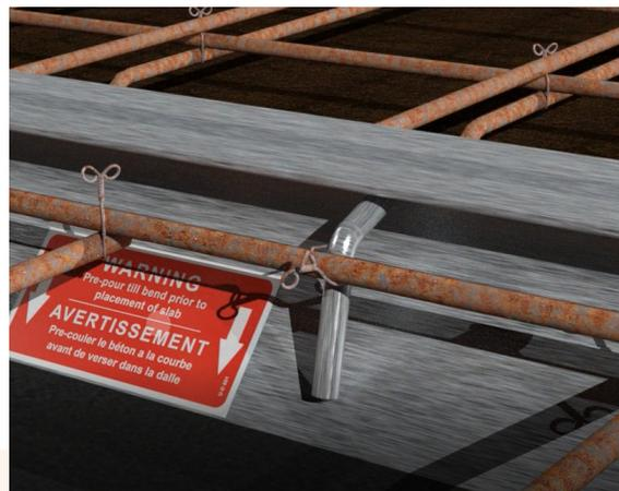
8. Pour garantir que le drain ne flottera pas, il est recommandé de couler le béton en deux étapes. Tout d'abord, versez le béton jusqu'à l'autocollant d'avertissement sur l'assemblage du drain et laissez le béton reposer. Une fois le temps nécessaire à la prise du béton écoulé, complétez la dalle de plancher. L'utilisation d'un vibreur crayon est fortement recommandée pour s'assurer que le béton a complètement entouré le drain, ne laissant aucune bulle ni vide.
